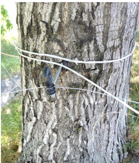
Isolatoren und Drähte wachsen innerhalb weniger Jahre ein.
